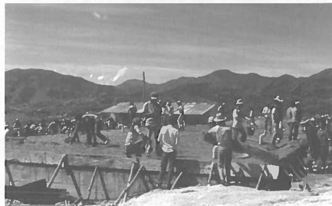
En la construcción del tanque de almacenamiento participó activamente gran parte de la comunidad beneficiaria de este acueducto.
